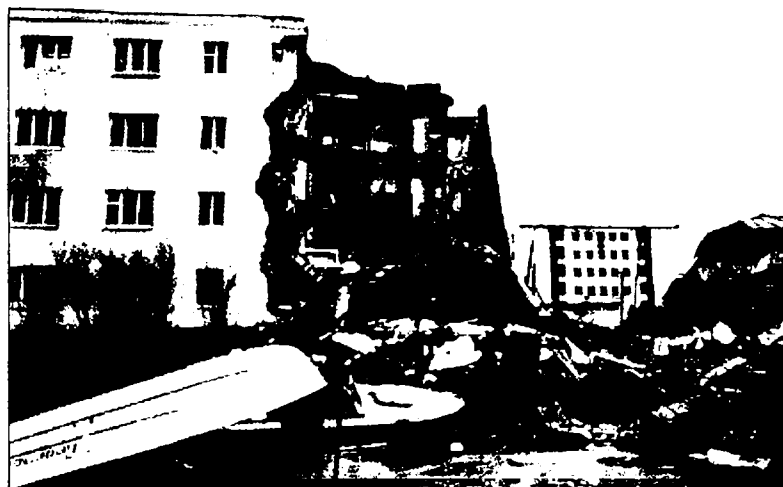
Рис. 3.11. Обрушившаяся из-за термокарста секция здания в пос. Черский
