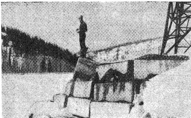
Рис. 3. Сдвиг льдом бетонных блоков основания опоры 82/2 (р. Томи в районе ст. Бельсу)
