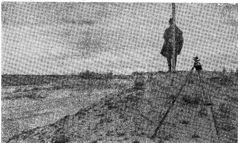
Рис. 2. Разрыв насыпи автогужевой дороги на пойме р. Надым (114-й км)
