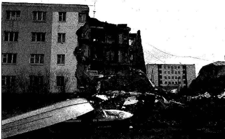
Рис. 3.11. Обрушившаяся из-за термокарста секция здания в пос. Черский
