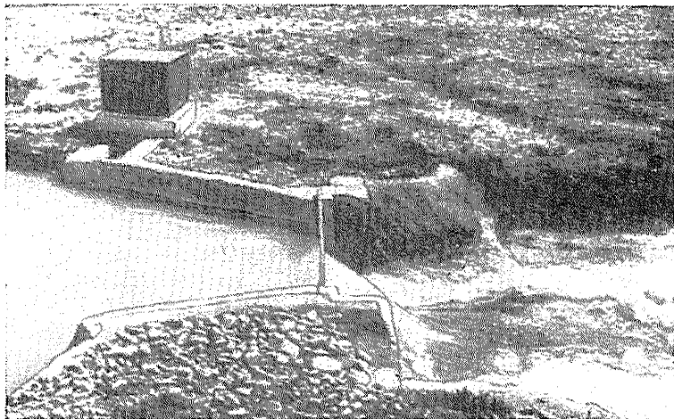
Рис. 16. Установка самописца уровня при водосливе.
