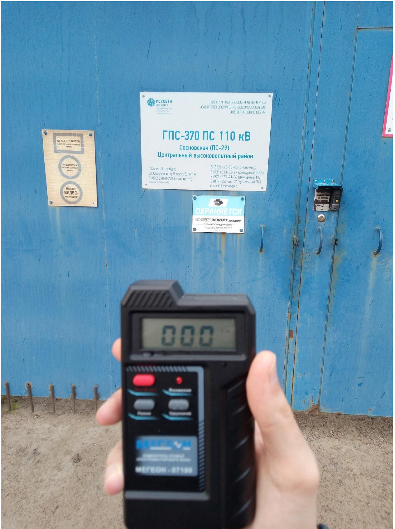
Рисунок 3.1.3 – Проведение замеров ЭМИ Сосновской подстанции
