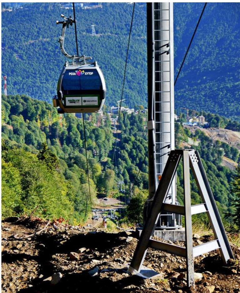
**Рис. 37. Лавинорез, защищающий опору канатной дороги от
