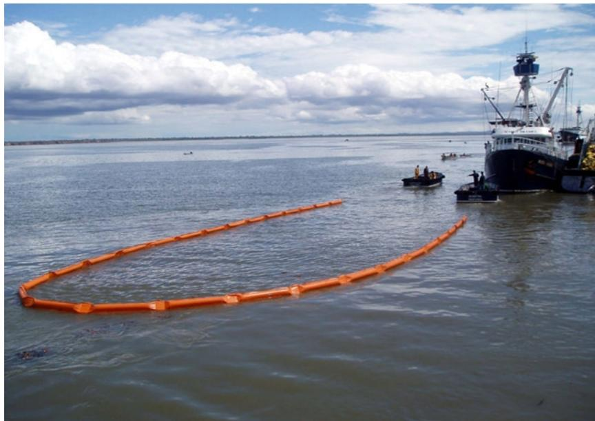
Рисунок 2.2 – Боновые заграждения постоянной плавучести цилиндрические
