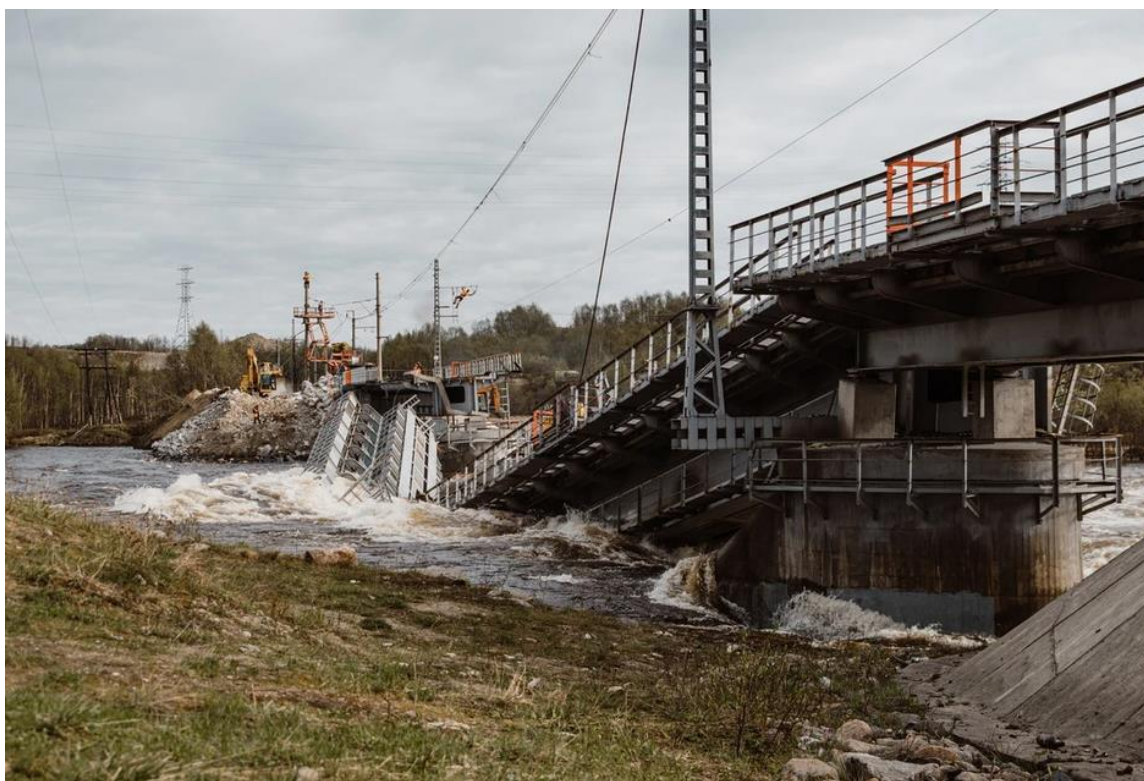
Рис. А1 Разрушение моста на реке Кола
