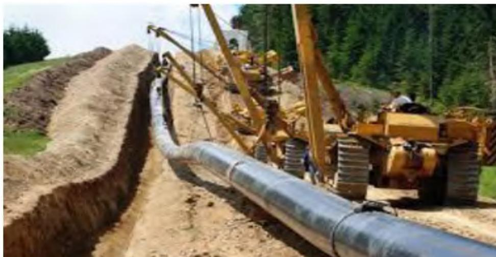
Рисунок 3 - Укладка газопровода Джубга-Лазаревское – Сочи [24, с. 169]
