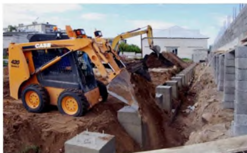
Рисунок 2.9 -Засыпка грунта
