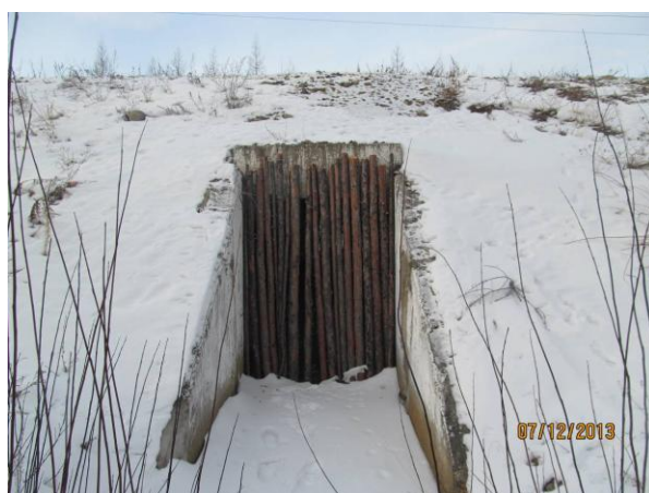
Рисунок 5.9 – Водопропускное сооружение водотока № 3
