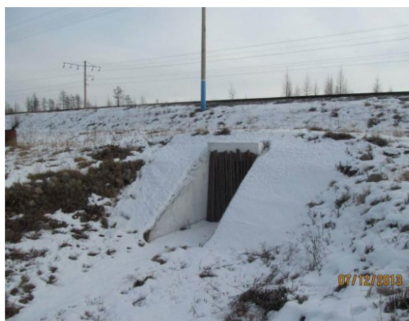
Рисунок 5.5 – Водопропускное сооружение водотока № 2
