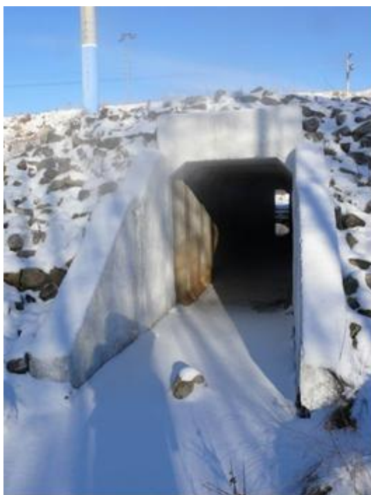
Рисунок 5.2 – Водопропускное сооружение водотока № 1
