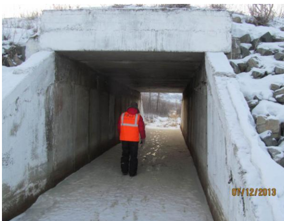
Рисунок 5.18 - Водопропускное сооружение водотока № 6
