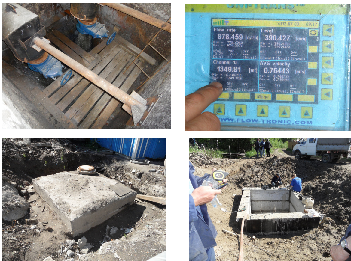
Рис. 1. Элементы процесса установки системы учета воды
