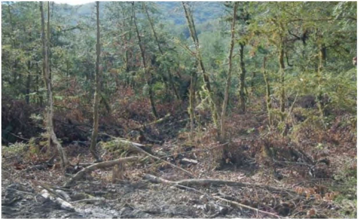
Рисунок 2.6 – Участок самшитового леса при строительстве автодороги
