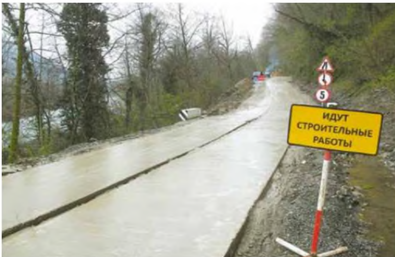
Рисунок 2.1 – Строительство автомагистрали Адлер - Красная Поляна
