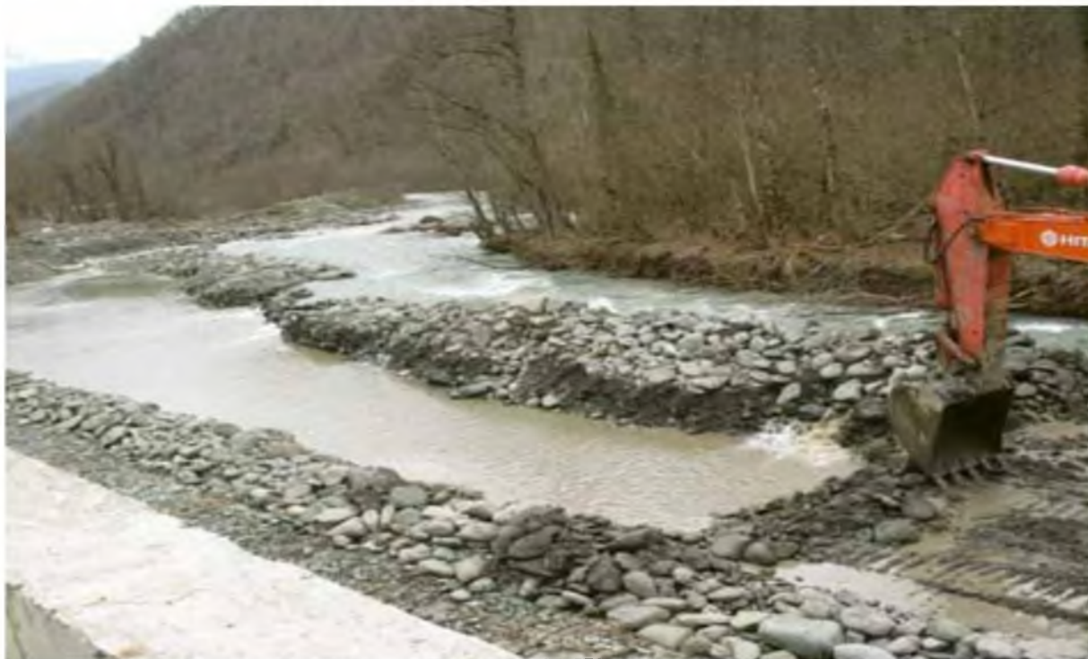
Рисунок 1.4 – Проведение технических работ на реке Мзымта
