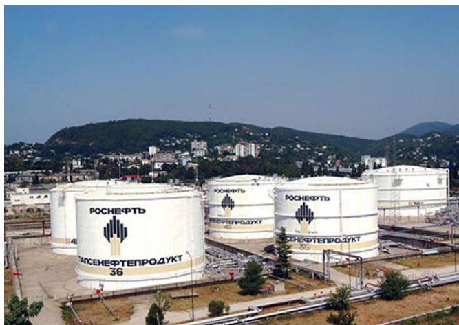
Рис. 2.2 Резервуарный парк ООО «РН-Туапсенефтепродукт» 3
