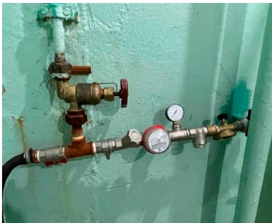
Рисунок 2.5 – Пример пробоотборной системы, встроенной в проточную систему судна (Ершова, 2022).
