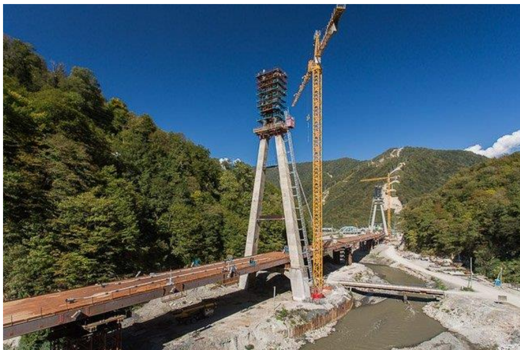
Рисунок 1.7 – Строительство Адлеровского моста
