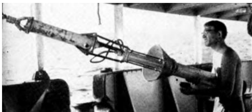
Рисунок 2.2 – Зондирующий батифотометр [24]
