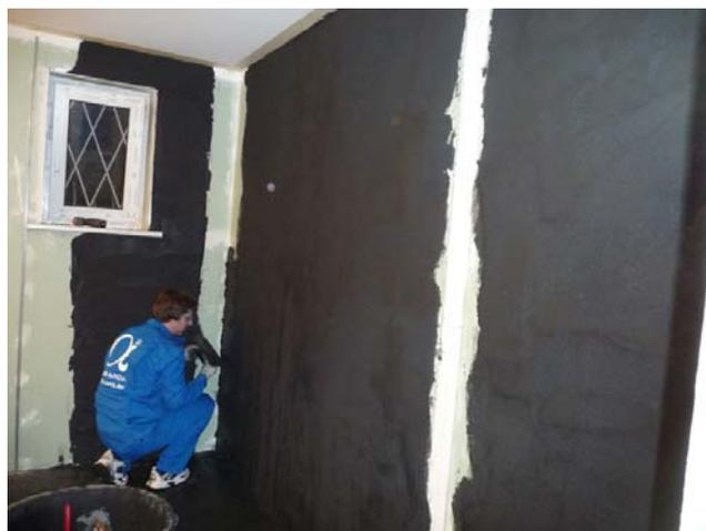
Рисунок 5.2 Использование шунгитовой штукатурки для защиты от электромагнитного поля
