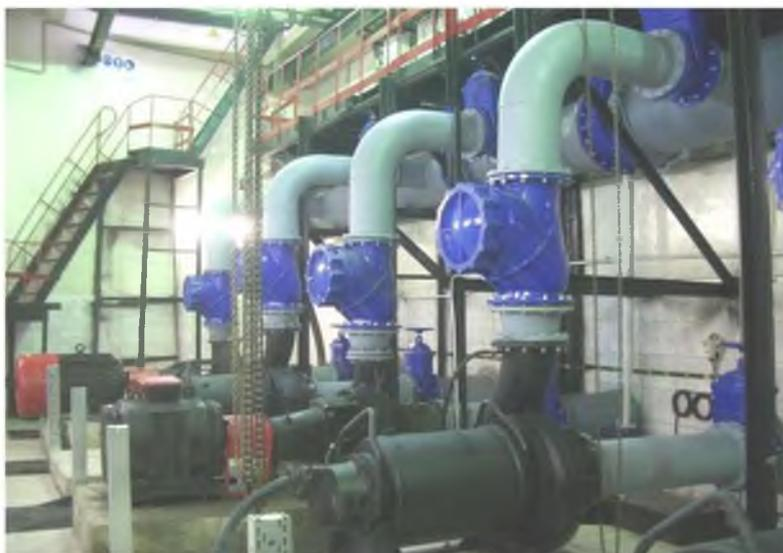
Рисунок 3.3 – Современное автоматизированное машинное отделение КНС
