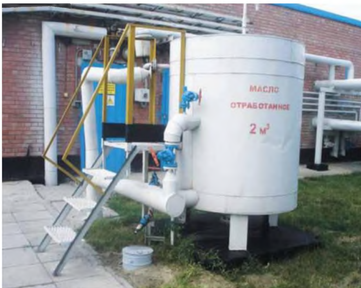
Рисунок 2. Правильно оборудованное место накопления отработанного масла.
