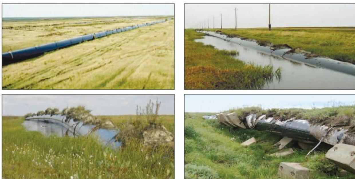
Рис. 7 Нарушения проектного положения газопроводов из-за растепления многолетнемерзлых грунтов
