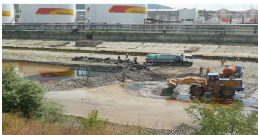
Рисунок 2.13 — Работа техники по изъятию грунта
