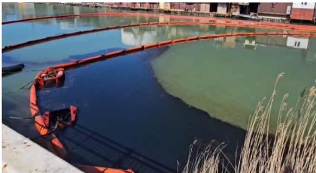
Рисунок 3.4 — Плавающие надводные боны в несколько рядов
