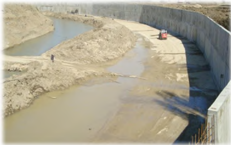
Рисунок 20- Берегоукрепительные работы на реке Адагум [11,с.12]
