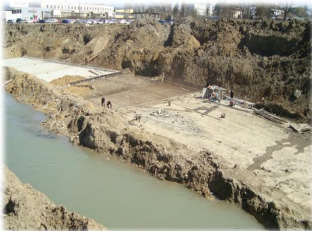
Рисунок 21 - Дноуглубительные работы на реке Адагум [11,с.12]
