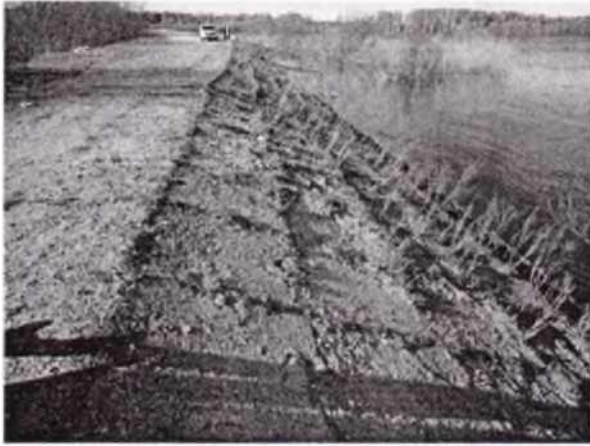
Фото 2.8 - Берегоукрепление из насыпных сооружений, ведущих к струенаправляющей дамбе.
