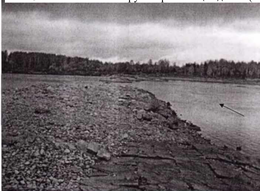
Фото 3.1 - Затопленная струенаправляющая дамба (май 2014 г.)
