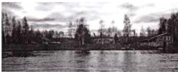
Фото 10 - Берегоукрепление дамбы затона для отстоя судов
