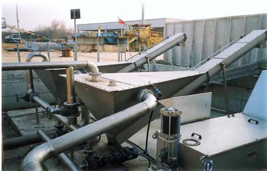
Рисунок 1.8 – Комбинированные решетки-дробилки [15, с.97]
