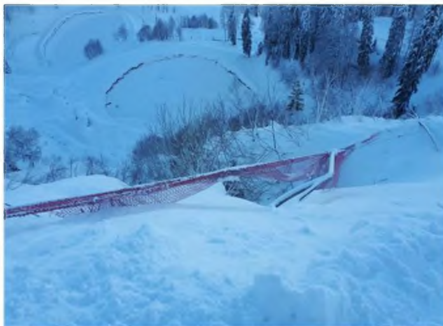
Рисунок 3.12 – Лавина №77, разрушенный четырех опорный стационар
