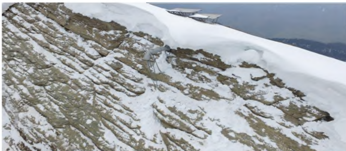
Рисунок 2.7 – Общий вид системы «Газекс»
