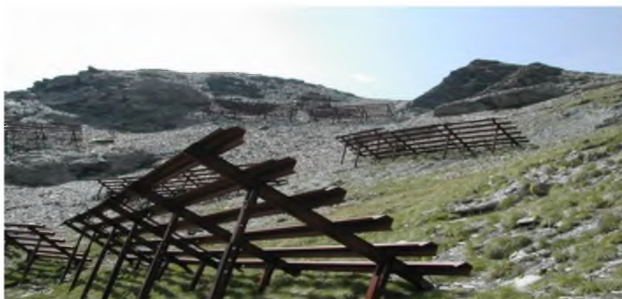
Рисунок 1.8 - Снегоудерживающие щиты с дополнительными усилениями
