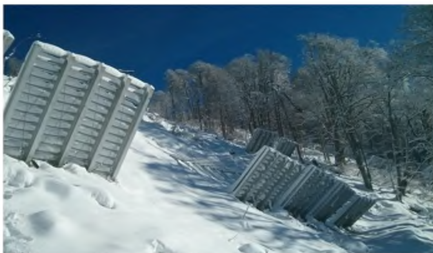
Рисунок 1.6 – Металлические снегоудерживающие щиты
