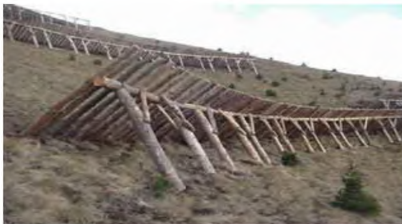
Рисунок 1.7 — Деревянные снегоудерживающие щиты
