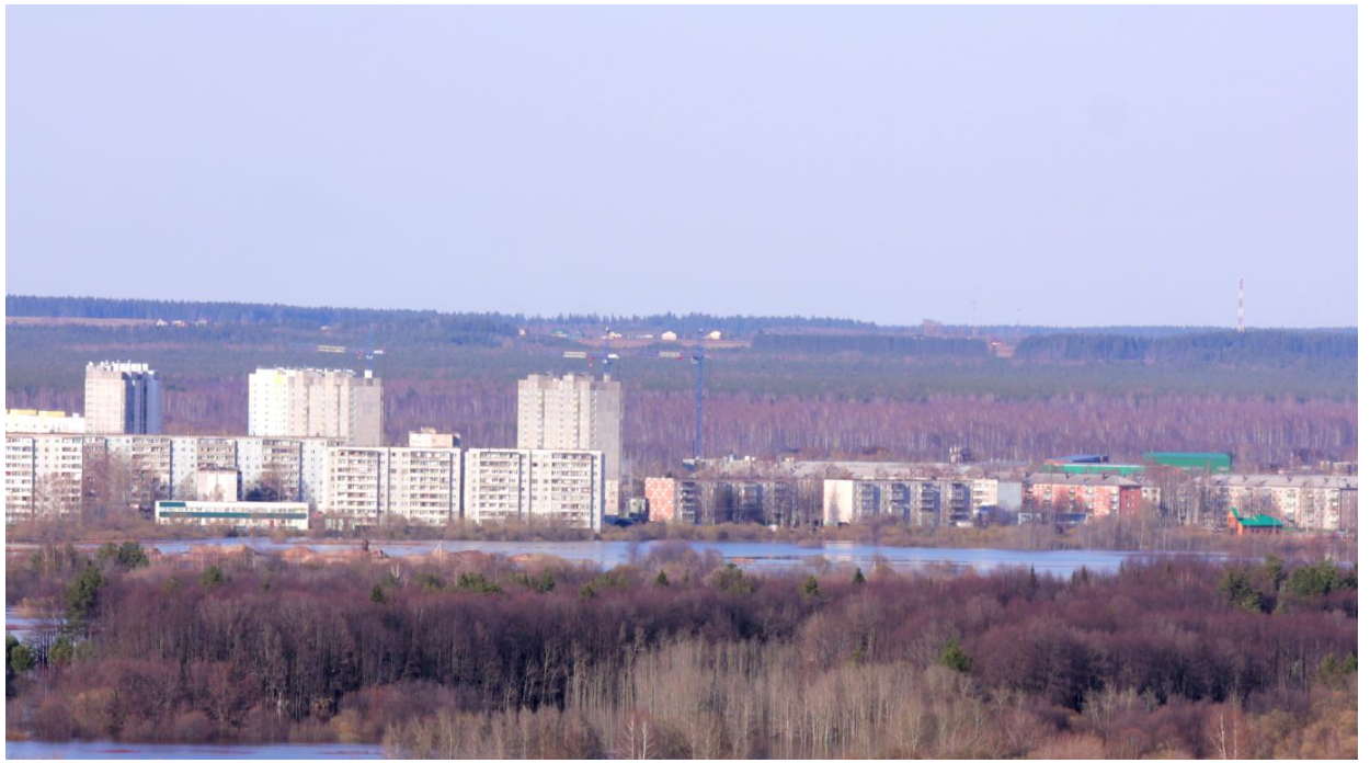
Рисунок 3.14 Весеннее половодье 2016. Подтопление многоэтажных жилых домов по ул. 60 лет Комсомола г. Кирова.
