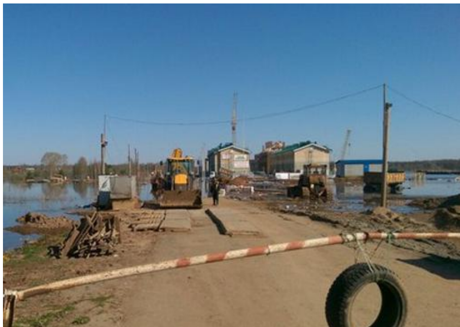
Рисунок 3.16 Затопление проезда к слободе Новое Сергеево. Весна 2016
