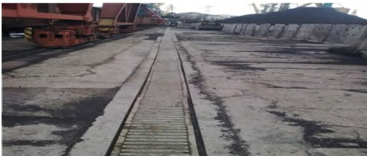
Рисунок 3.9 – Ливневая канализация
