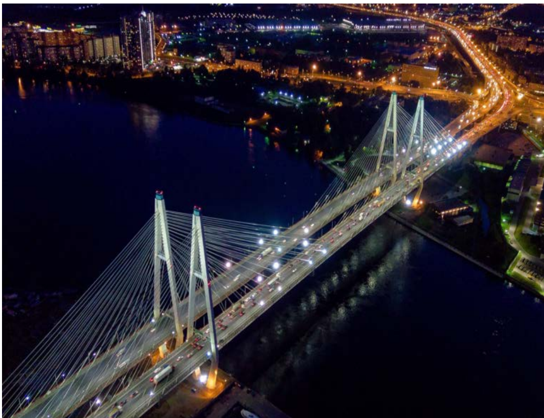
Рисунок 1.2 – Большой Обуховский мост
