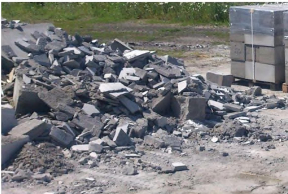
Рисунок 3.1 – Типичные отходы строительства
