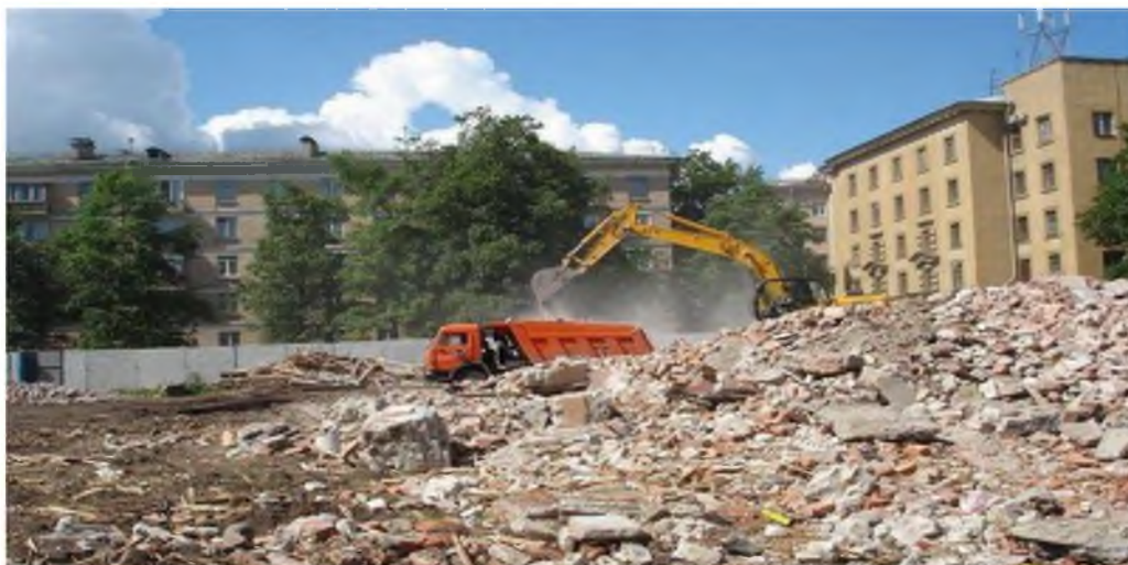
Рисунок 3.3 – Пример образования отходов при сносе строительных объектов
