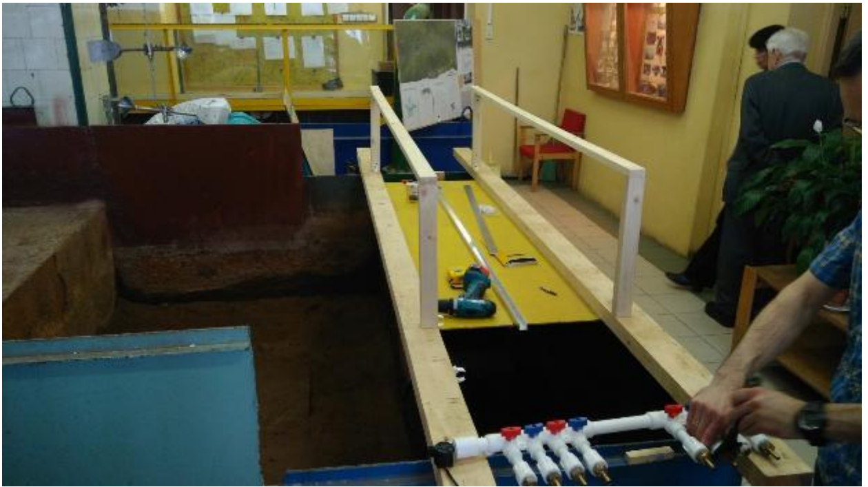
Рисунок 3.4 – Сборка каркаса и установка коллектора с расходомером
