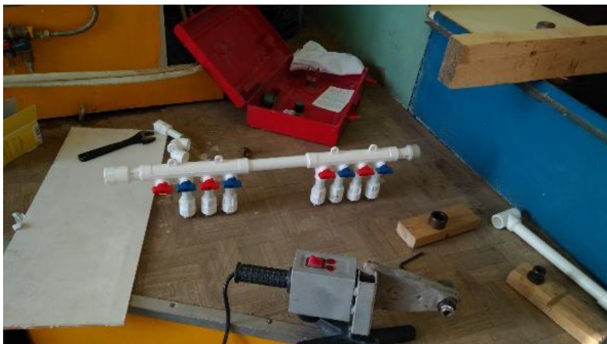
Рисунок 3.3 – Изготовление распределительного коллектора
