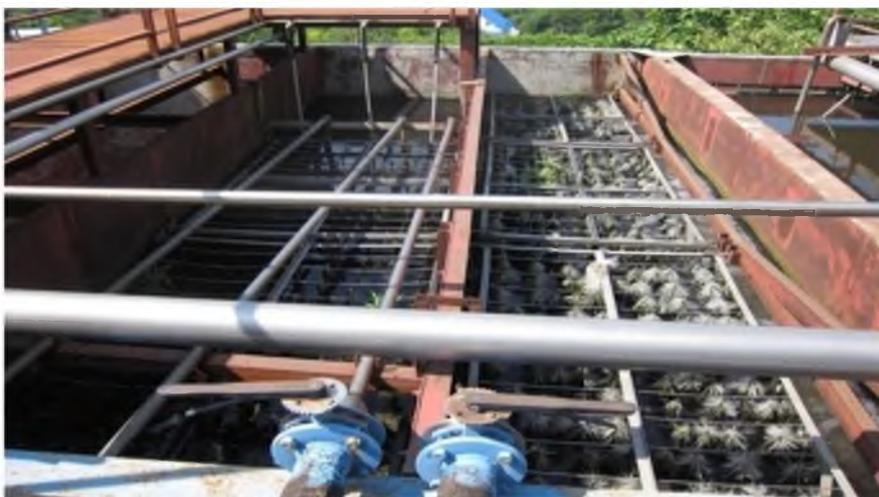
Рисунок 2.9 – Блок доочистки
