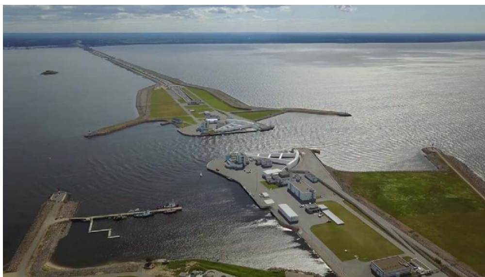
Рисунок 1.5 – Комплекс защитных сооружений с высоты птичьего полета [12]
