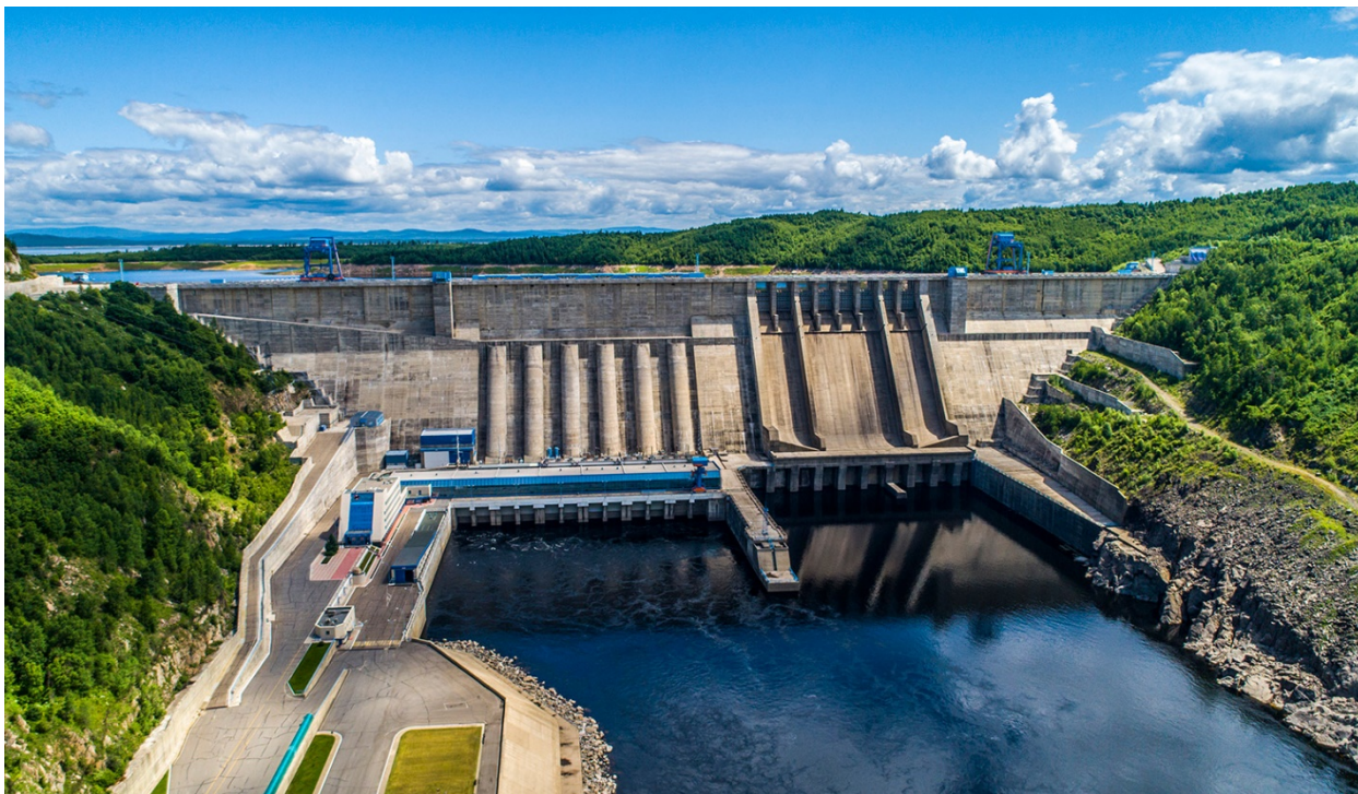
Рисунок 2.1 – Вид на Бурейскую ГЭС
