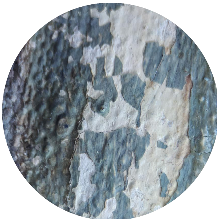
Ил.1. Участок механического повреждения в центральной части на загибе верхней кромки
