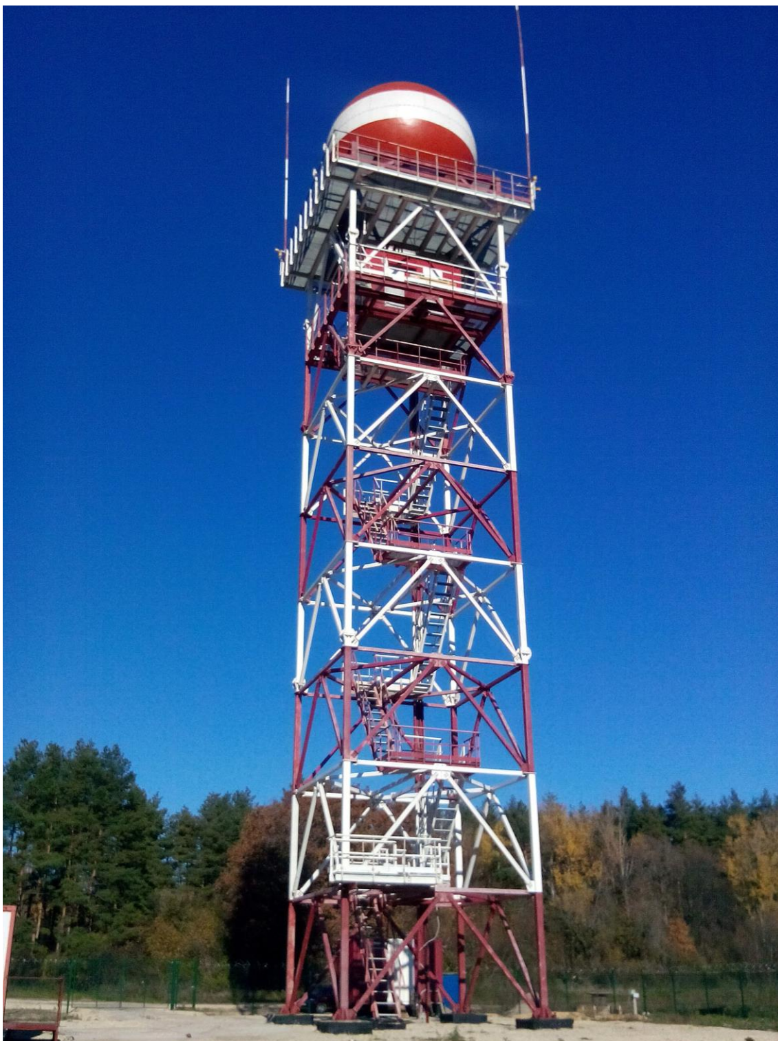
Рисунок 7 – Доплеровский метеорологический радиолокатор (ДМРЛ) [12].
