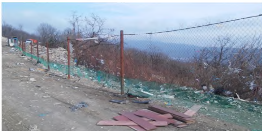
Рисунок 2.3 – Ограждение полигона ТБО
