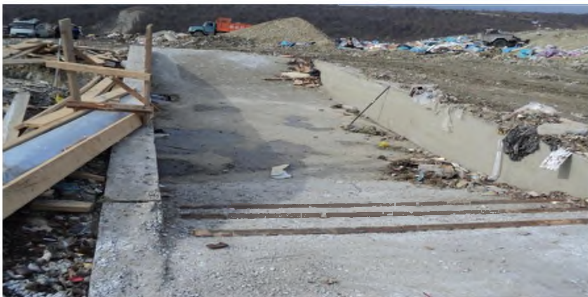
Рисунок 2.5 – Дезбарьер для дезинфекции ходовой части мусоровоза
