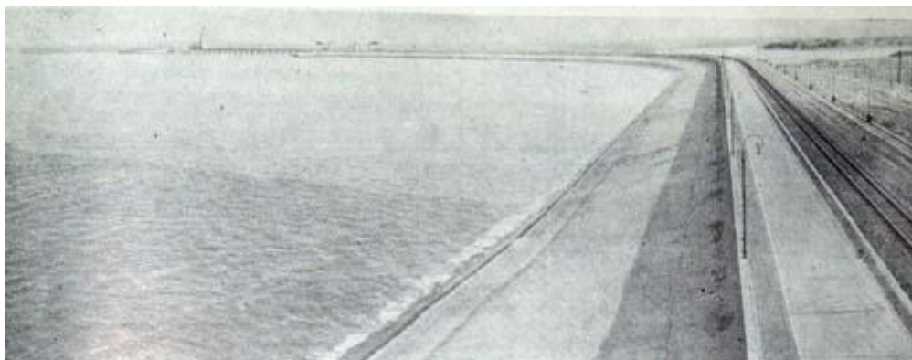
Рис.7. Земляная плотина на участке правобережной поймы
