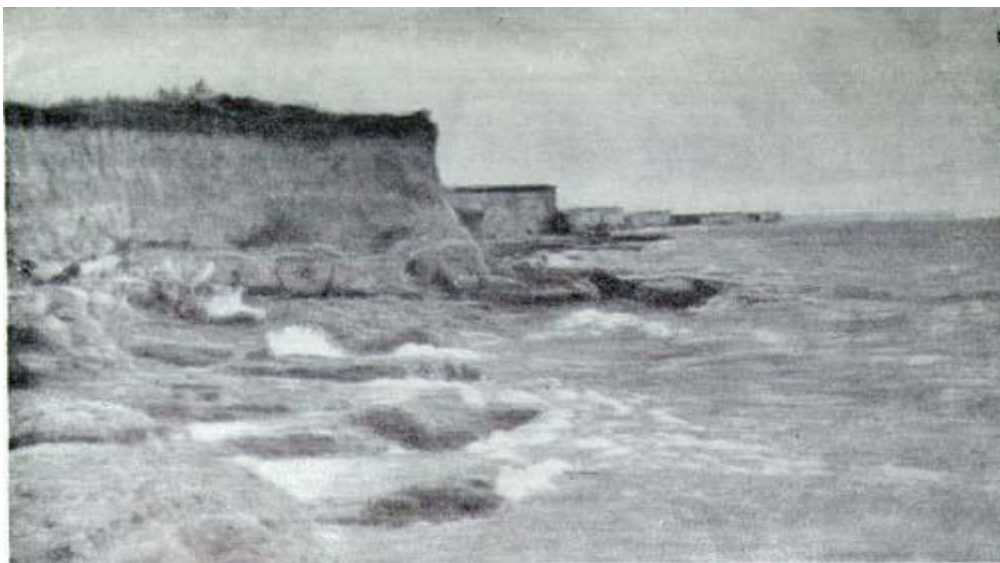
Рис. 4 Переформирование берега Цимлянского водохранилища в районе убежища Кривского (апрель 1953 г.) На переднем плане виден обрыв, сложенный лессовидными суглинками; за ним откос из тех же суглинков, подстилаемых песками.
