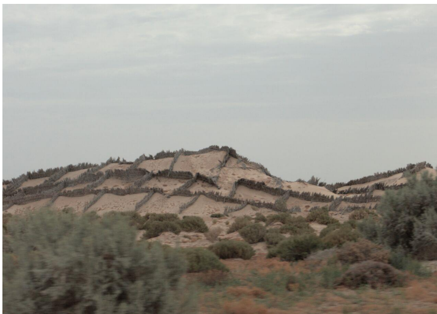
Рисунок 22 - Противопесчаные заграждения из тростника в Северной Сахаре, Тунис (Уразбаев, staff.ttiame.uz )
