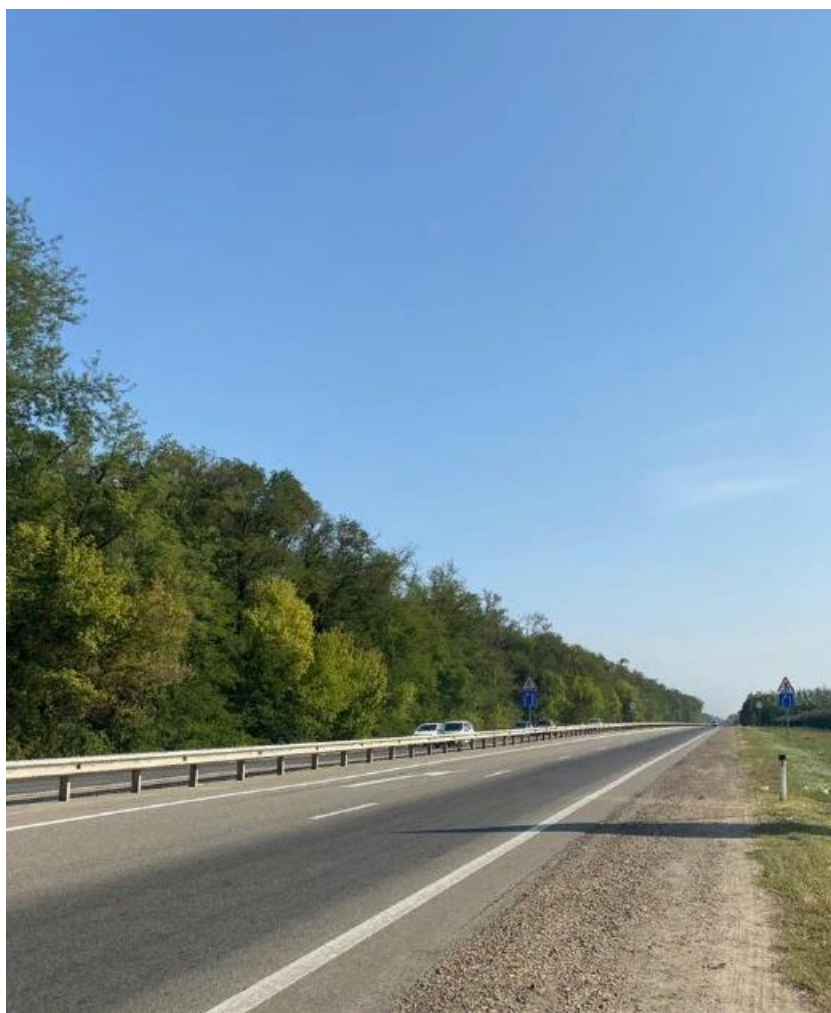
Рис. 4.5 Участок автодороги Краснодар – Ейск
