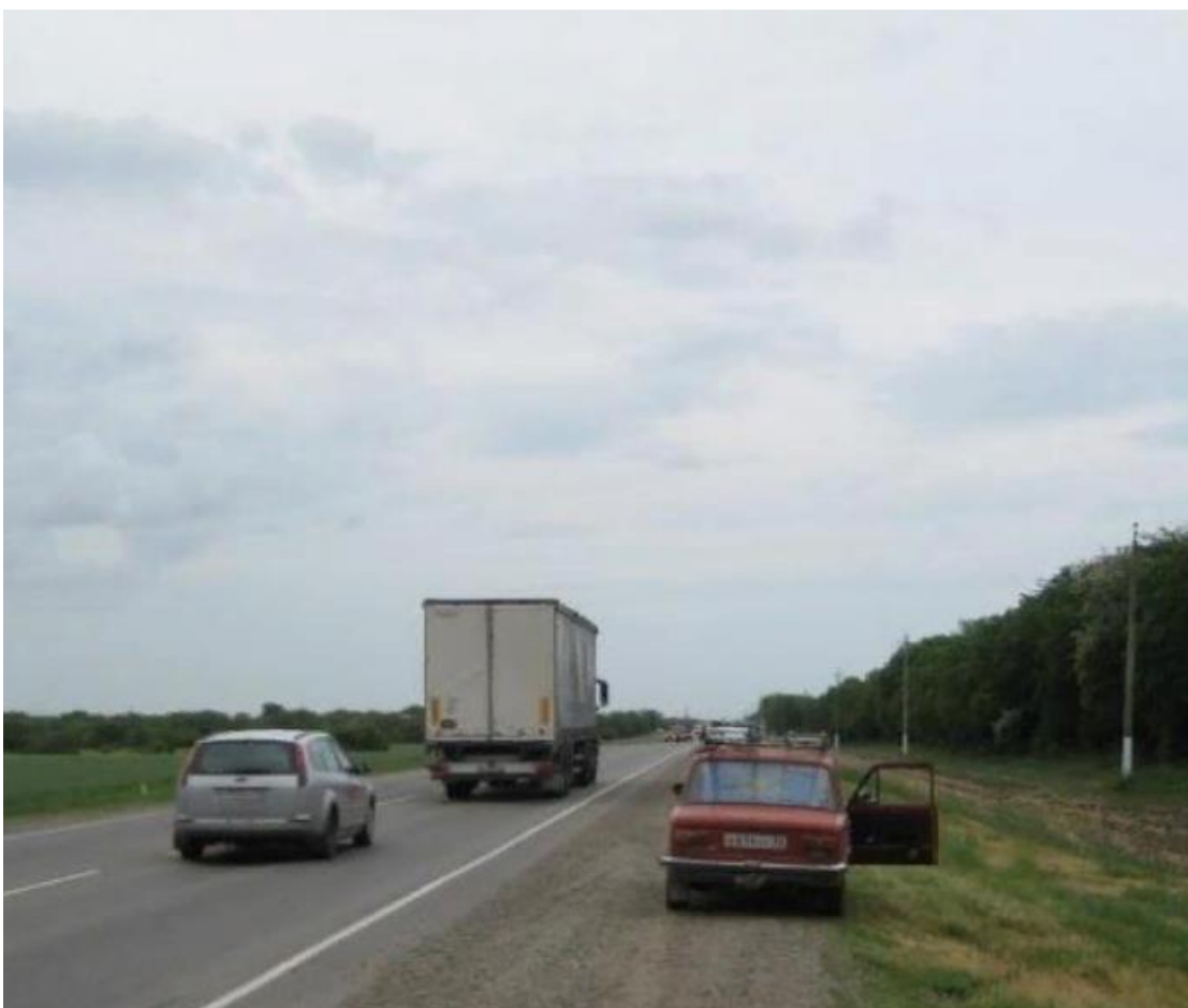
Рис. 4.6 Участок автодороги Краснодар – Ейск
