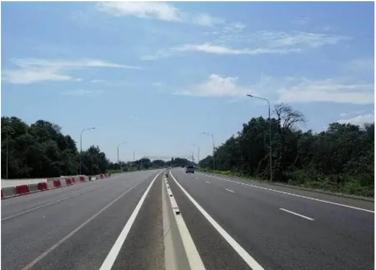
Рис. 4.3 Автодорога Краснодар – Ейск после реконструкции
