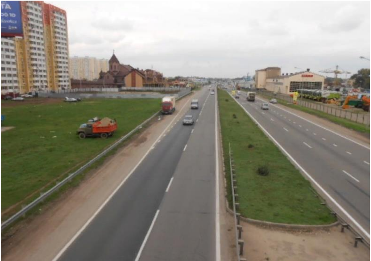
Рис. 4.4 Участок автодороги Краснодар – Ейск
