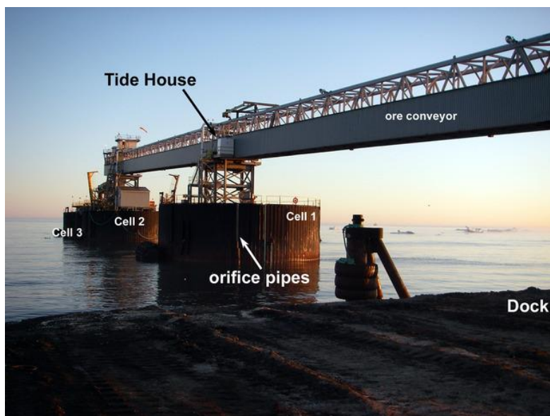
Рисунок 2.3 – Станция и ячейки с датчиками
