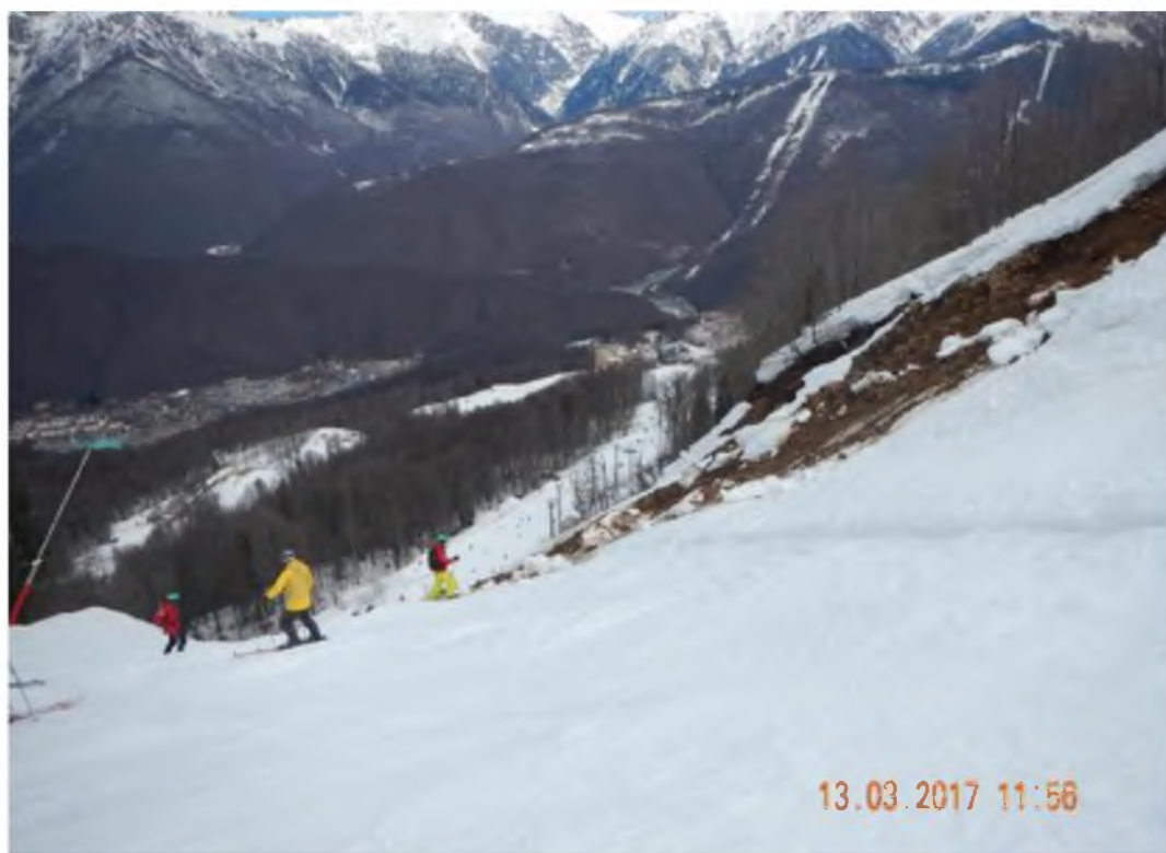
Рисунок 3.6 – Обрушение борта Центрального сектора Н – 1250 м н.у.м.
