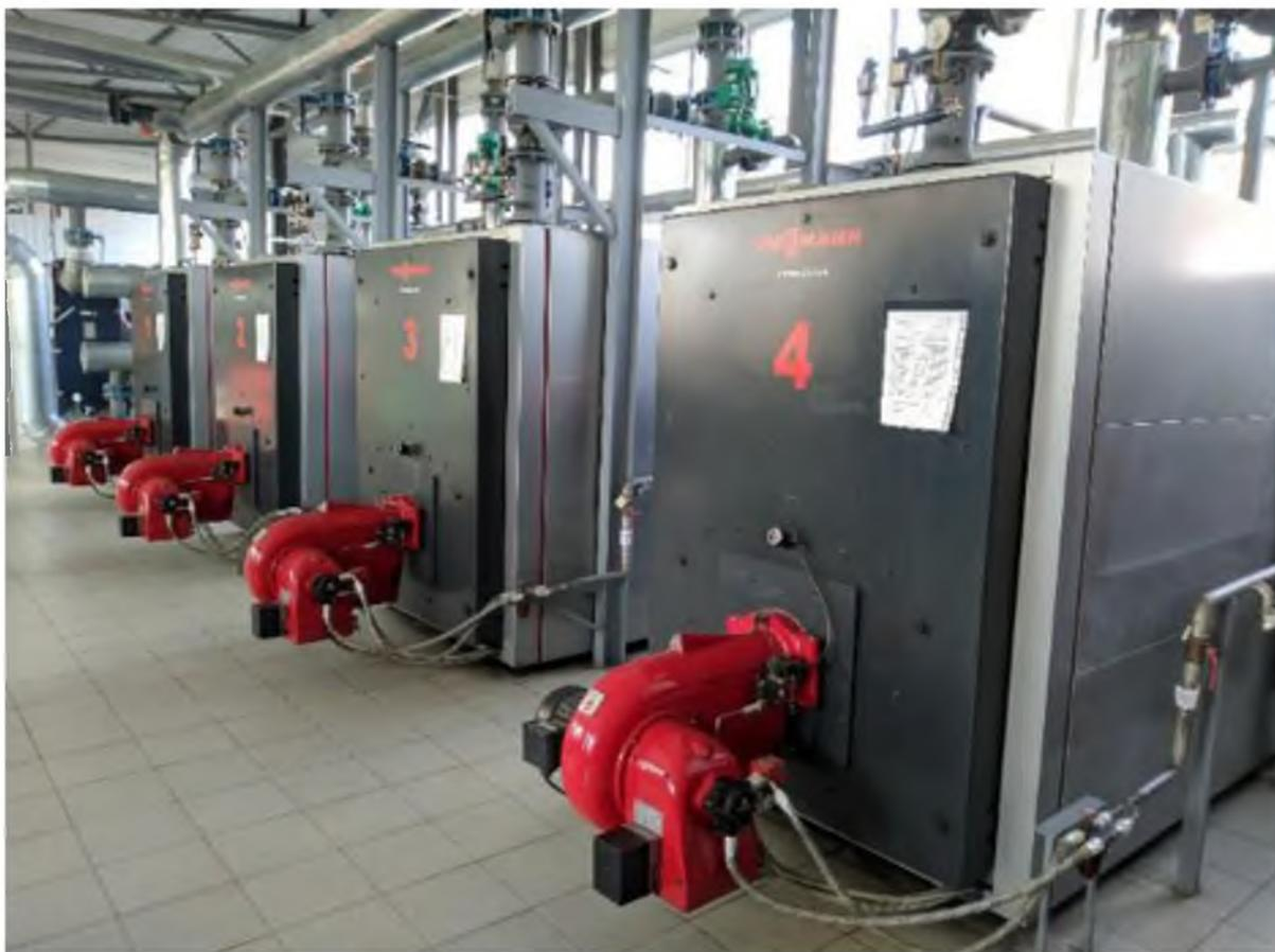
Рисунок 5 – Viessmann Vitoplex 100 SX1- водогрейный, трехходовой котел
