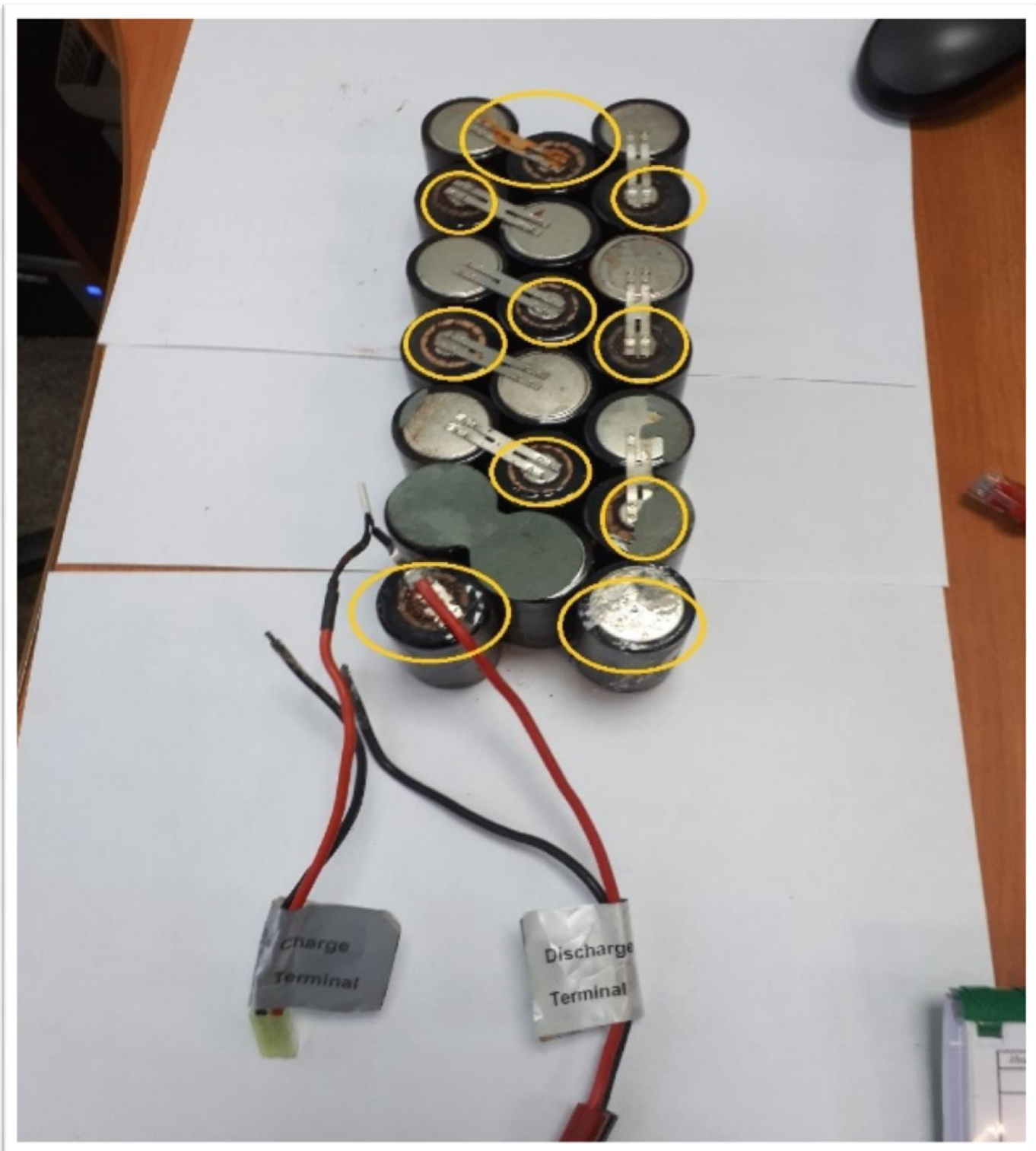
Рис. 5.4 Испорченная коррозией батарея от Q-Boat. Кружками обведены явные следы коррозии. Минусовые выводы к зарядному устройству и нагрузке полностью отгнили. (фотография автора).
