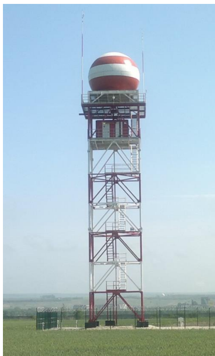
Рисунок 1.5 – Башня с установленным ДМРЛ [14]
