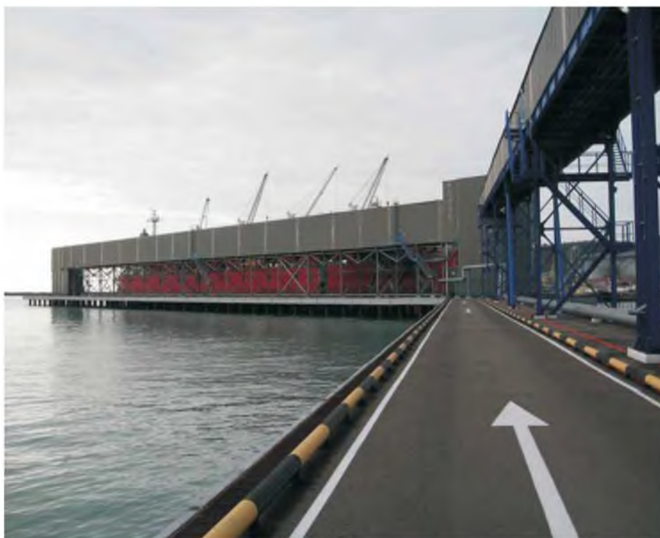
Рисунок 2.7 – Система конвейерных линий с пересыпными станциями
