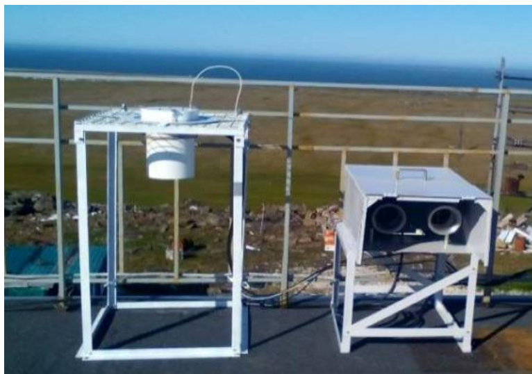
Рисунок 3.2.3—Установка выносимых блоков измерителей «Поле-2М» и «Электропроводность-2М» на метеостанции Диксон [8].
