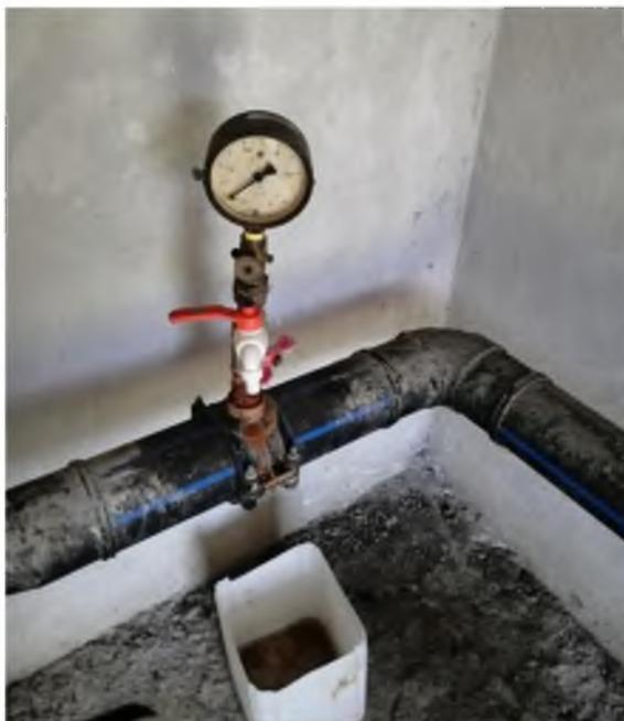
Рисунок 2.6 – Оборудование манометром и краном для отбора проб скважины
