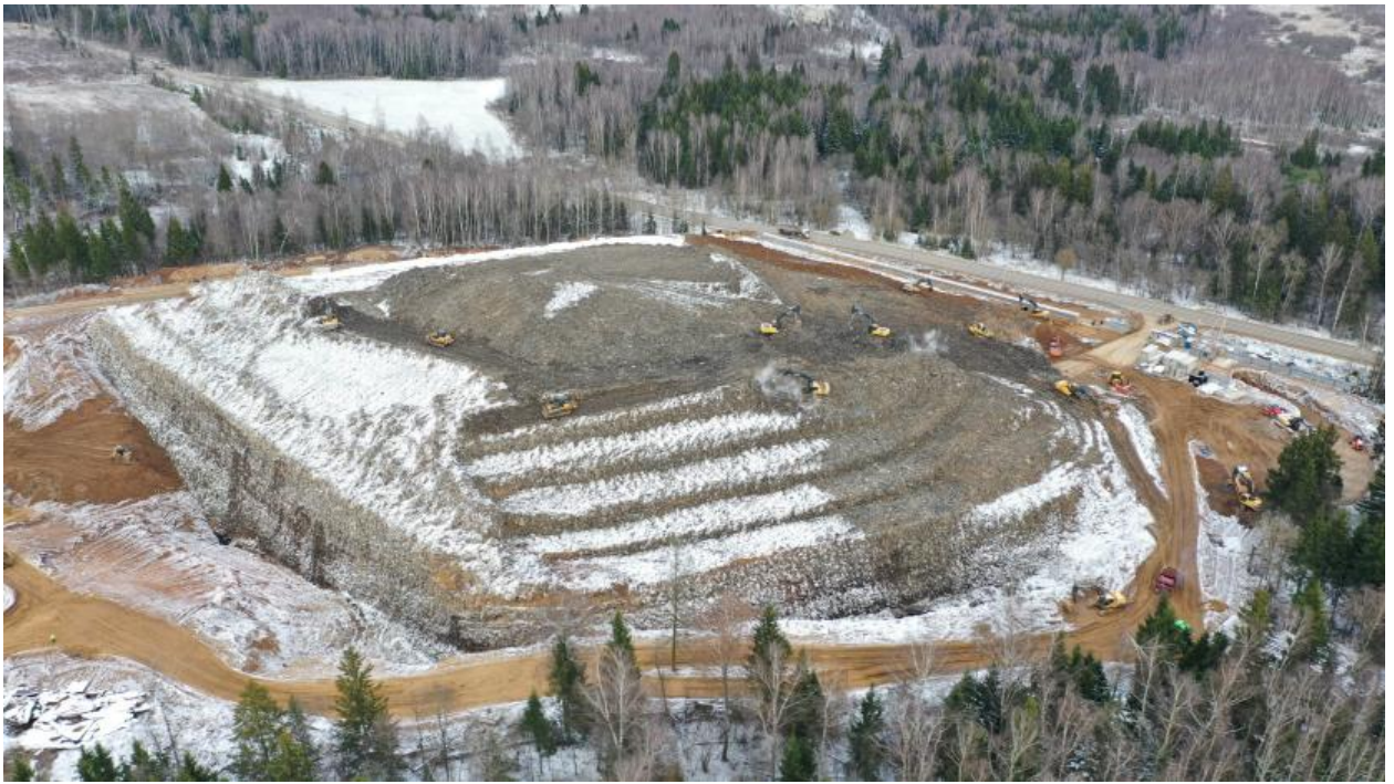
Рисунок 6 – Технический этап рекультивации полигона ТКО
